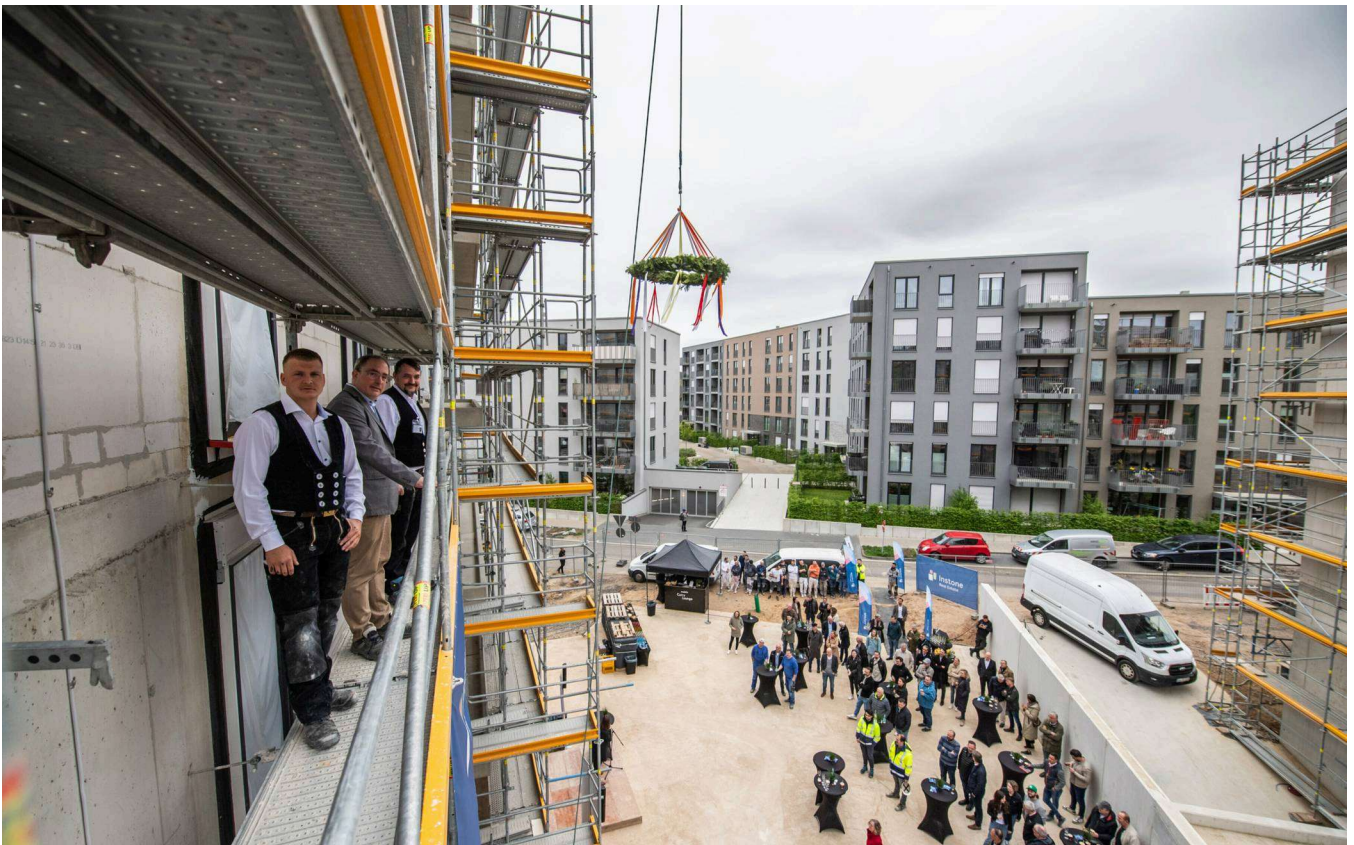
Dachdecker Fabio Bern (von links), Projektleiter Daniel Jaspers und Polier Marcus Krause stehen beim Richtfest auf dem Gerüst des Neubaus.
